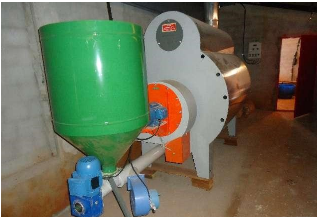
Fig. 4-Aquecedor de ara lenha para aviário
